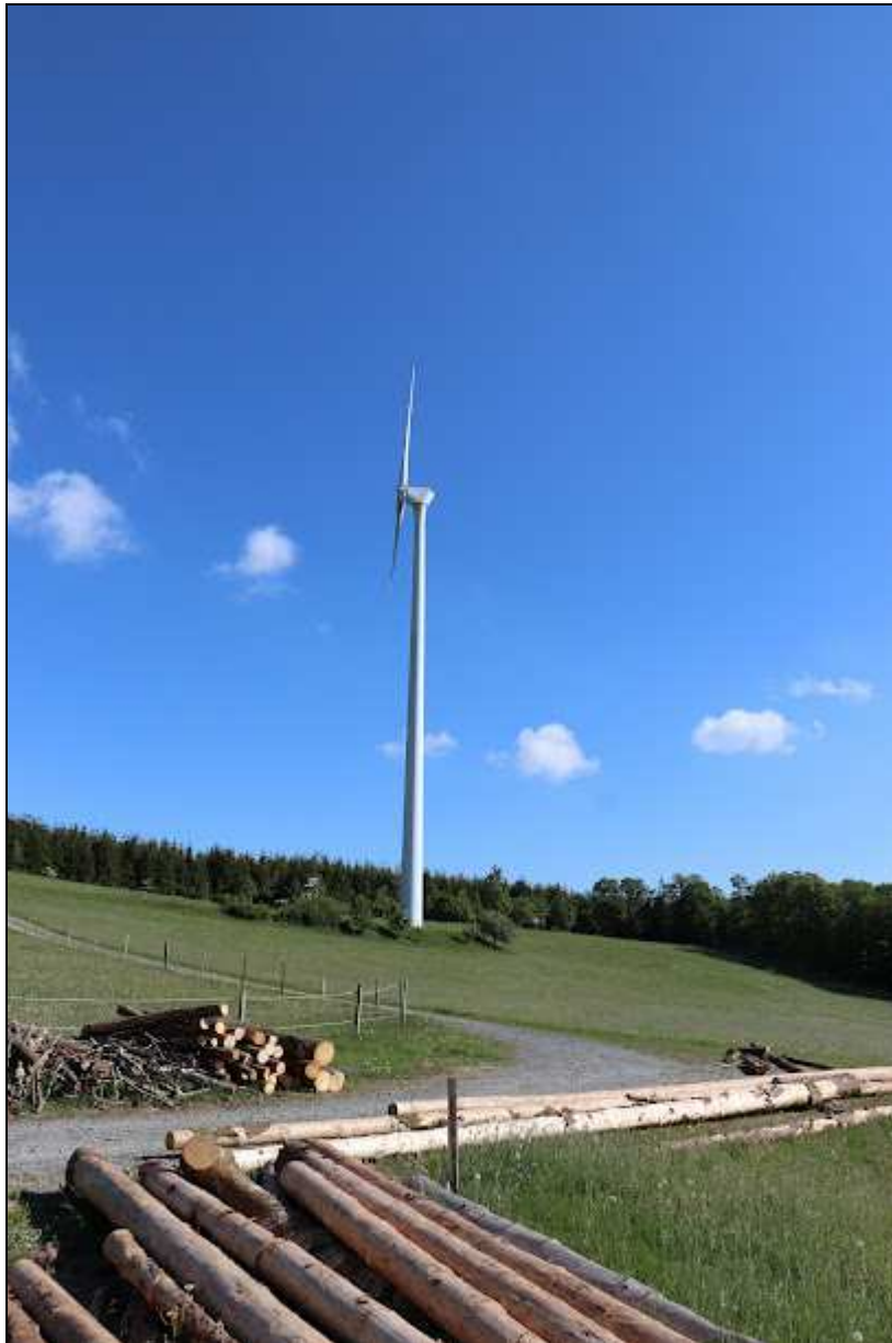
Abbildung 12: Standortansicht DeWind D4 600 kW, Gesamthöhe 94 m (Google Earth).
