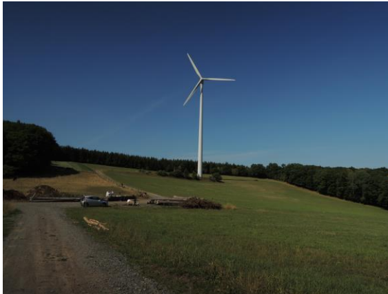
Abb. 3: Bestandanlage bei geplanter nördlicher WEA 1 (Standort rechts neben dargestellter Bestands-WEA)
